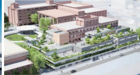
2号館北側新棟
