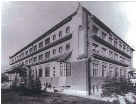
昭和11年竣工当時の外観（大宮図書館）
