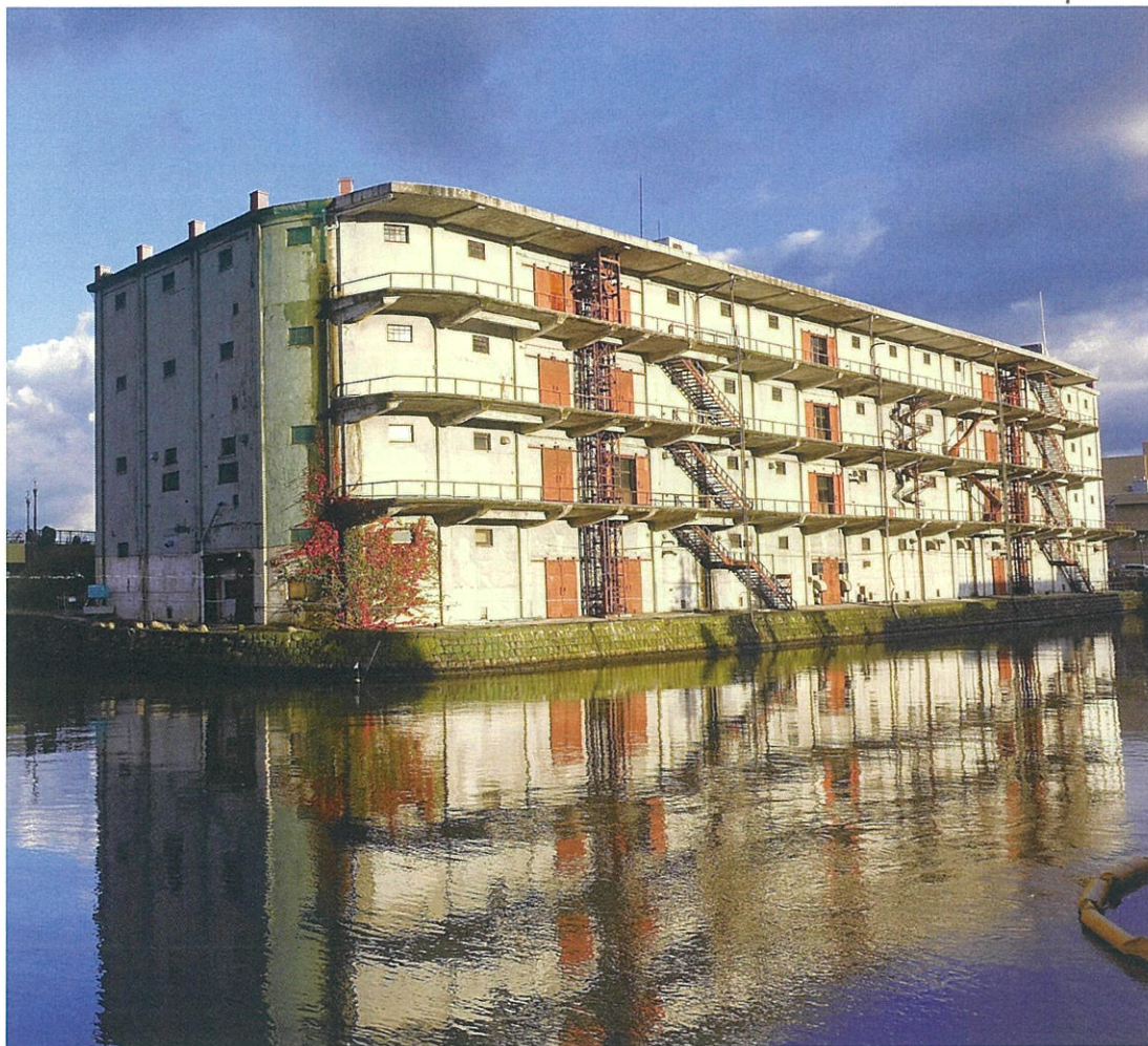
北海製罐第3倉庫（小樽市北運河）
